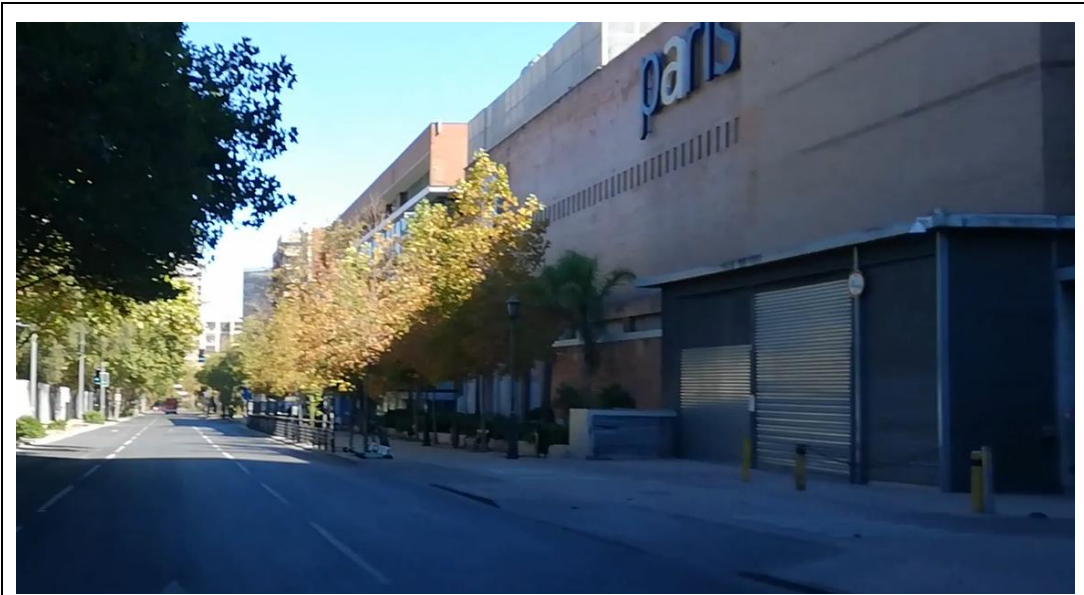
Accesos andén centro comercial
